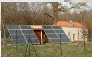
Installation photovoltaïque en site isolé pour une habitation. Lacépède [47360]
